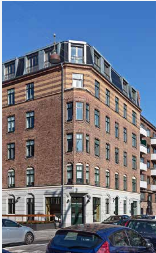
Den bevaringsværdige boligejendom Ryegade 25, beliggende tæt ved søerne i København, var det første renoveringsprojekt, som modtog en DGNB-certificering
