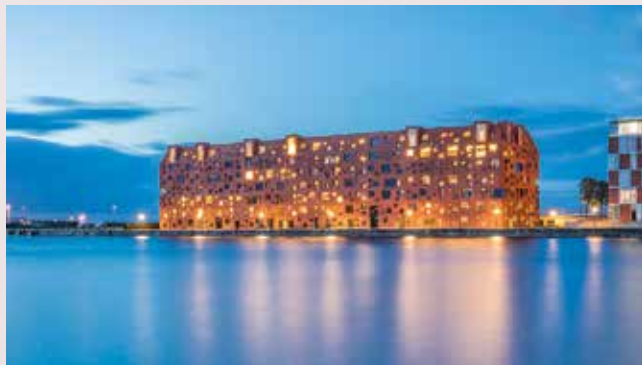
Pier47 på Langelinie Allé i Københavns Nordhavn er et eksempel på én blandt flere nyopførte ejendomme, som ATP Ejendommens portefølje rummer.
