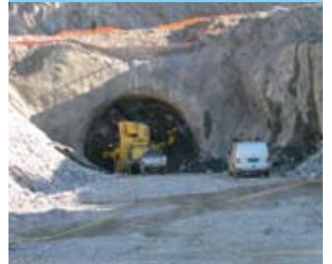
Tunnelriggen ved Torvund, Veidekke.
