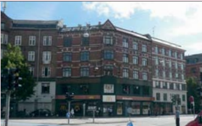
McDonalds ejendommen på Nørrebro Runddel rummer boliger på de øvre etager.
