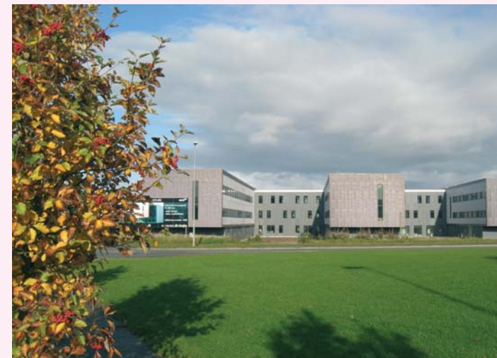
De to ejendomme er på henholdsvis 7.200 og 6.800 kvm. og 86 procent af arealet er udlejet. De største lejere er Region Midtjylland, Eniro, Hewlett-Packard, Codan Forsikring, Vestas og Rådgivergruppen DNU, der er rådgivere på det nye milliardsygehusbyggeri i området.
