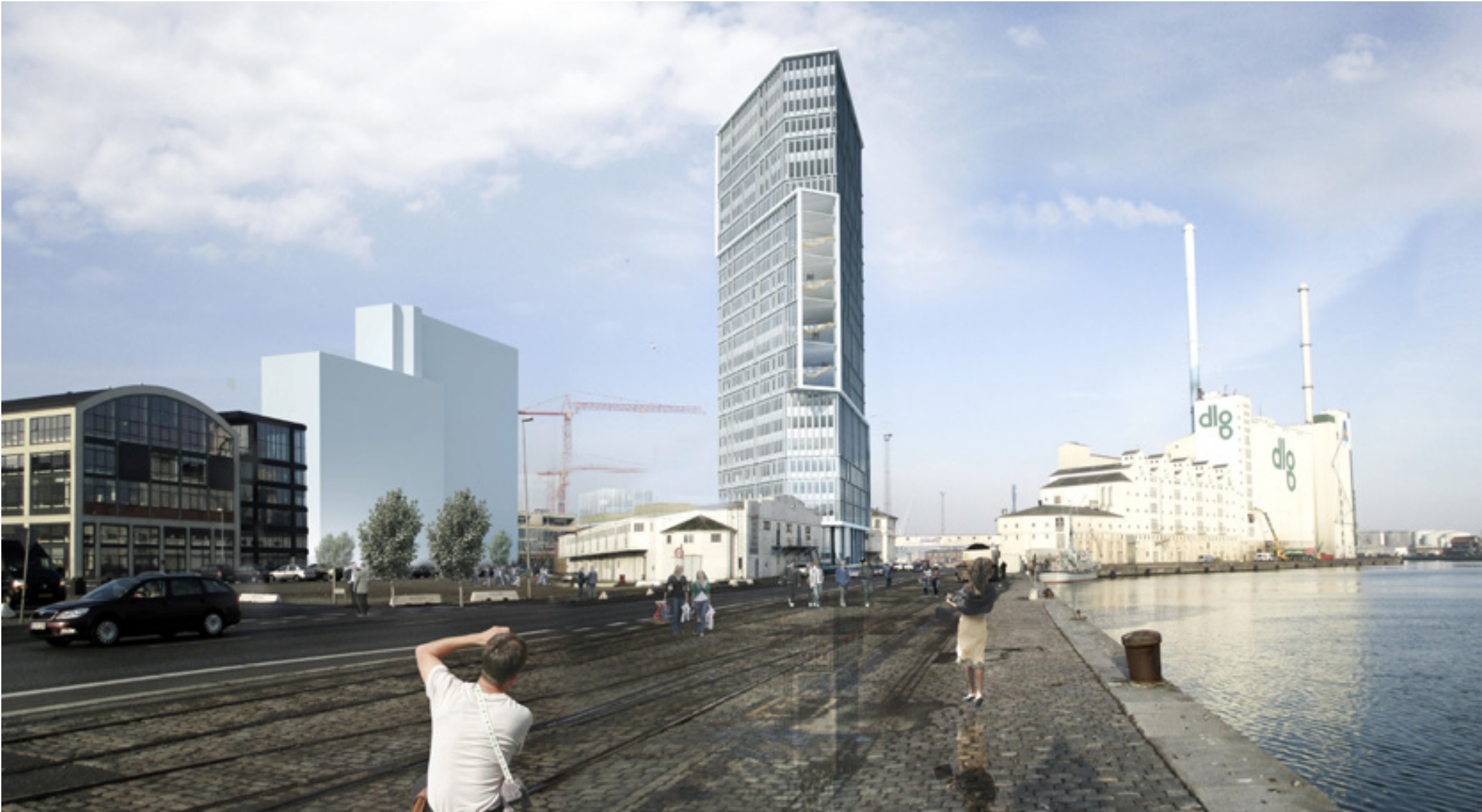
FOTO: BYGGESELSKABET OLAV
