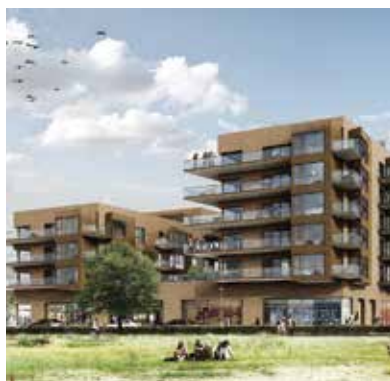
Strandgården · Amagerstrandpark 56 ejerlejligheder Bygherre: ELF Development
