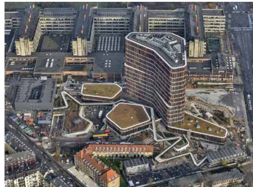
FOTO: DABAGER LUFTFOTO
