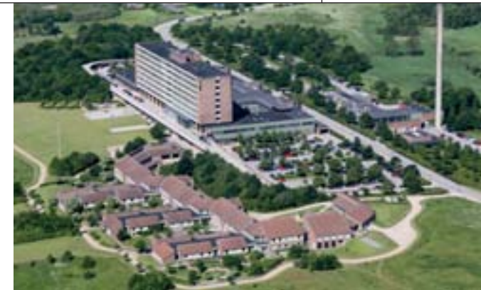
Haderslev Sygehus består af 61.000 kvm. på en 379.000 kvm. grund med udsigt over Haderslev dam. Kun dele af sygehuset bliver rømmet i 2013, mens resten bliver fraflyttet i 2018.
