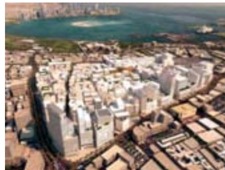
Qatars Musheireb-kvarter er et areal på 35 hektar, der skal udbygges i løbet af de kommende år.
