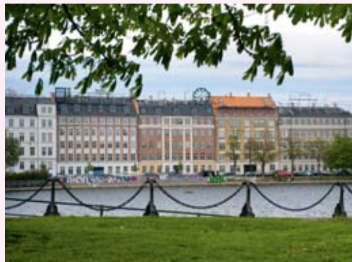
Boligkomplekset SD Karréen er på i alt 25.000 kvm. og ligger lige ud til Sortedamssøen og Dronning Louises Bro i København. Bygningerne er opført mellem 1871 og 1890'erne. Irma har haft sit hovedsæde i baggården, der tillige var lager for alt fra kaffe til smør. Bygningen er berømt for neonreklamen med Irmas høne, der lægger "friske æg" på facaden.
