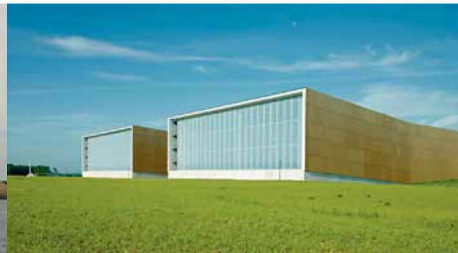
Bestsellers nye logistikcenter i Haderslev er på 48.000 kvm., men den fleksible indretning gør det muligt på sigt at udvide logistikanlægget til tredobbelt størrelse, dvs. 150.000 kvm.
