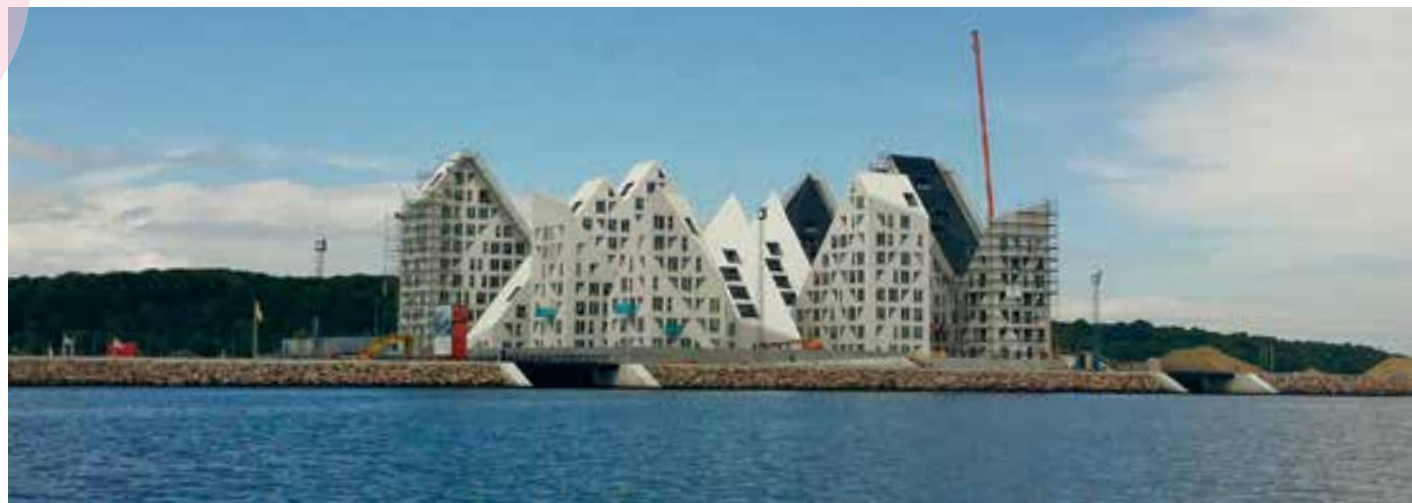
PensionDanmarks boligbyggeri Isbjerget i Aarhus Ø er tegnet af Cebra, JDS Architects og Louis Paillard. Isbjerget sikrer Århus 210 nye lejligheder, når byggeriet står færdigt i marts 2013. Det er på 30.000 kvm. NCC Construction Danmark har været totalentreprenør, mens Arkitema, Cowi og advokatfirmaet Kromann Reumert har været bygherrerådgivere.
